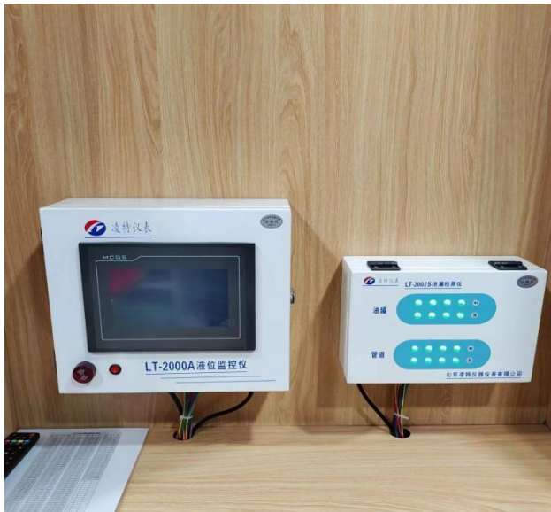
图 3-3 在线液位监控仪
