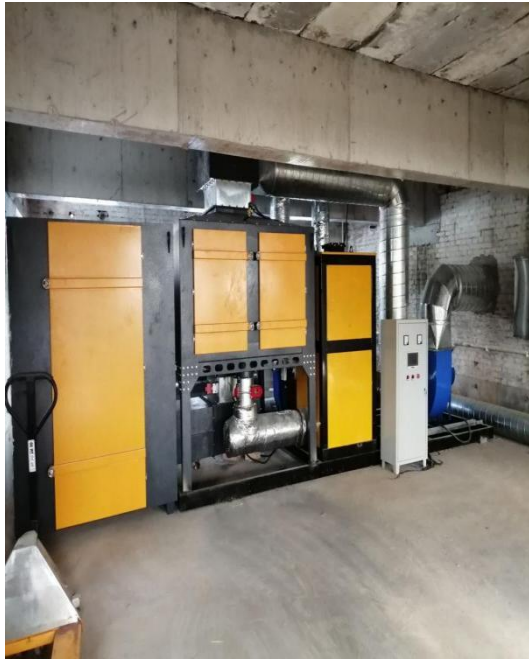
过滤+吸附+蓄热式催化燃烧 DA003 排气筒
