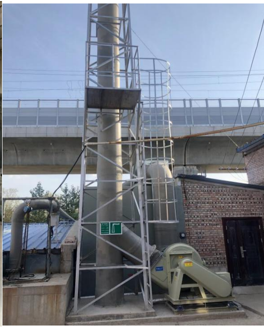
过滤+吸附+蓄热式催化燃烧 DA003 排气筒
